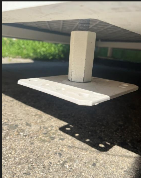
Pieds réglables jusqu'à 45mm. Entre le sol et le bas de la structure se trouve un vide sanitaire de 55mm, ensuite se trouve l'amplitude de réglage pouvant aller jusqu'à 45mm, le mini entre le sol et la structure est de 55mm et le maximum avec le réglage des pieds est de 100mm.
