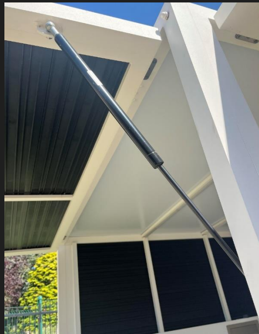
Système d'ouverture et de fermeture avec vérins nautique testé en brouillard salin
